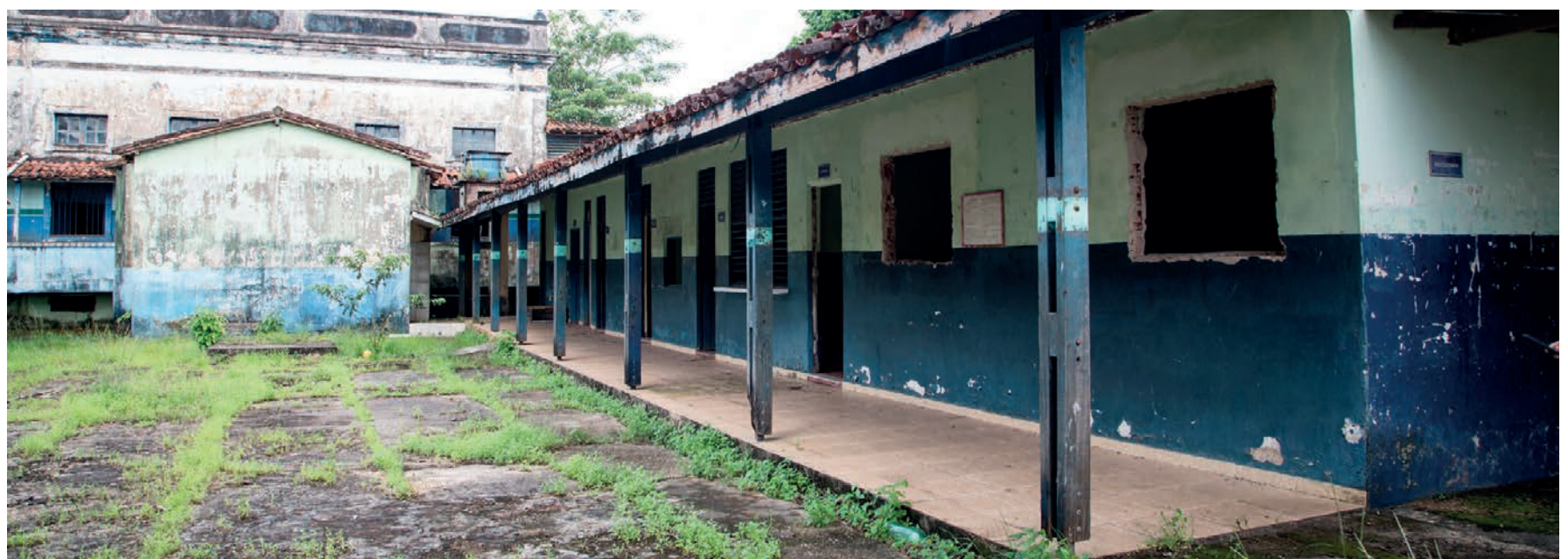
Prédio anexo da antiga escola será revitalizado (Foto: Eder Souza/Ascom)
