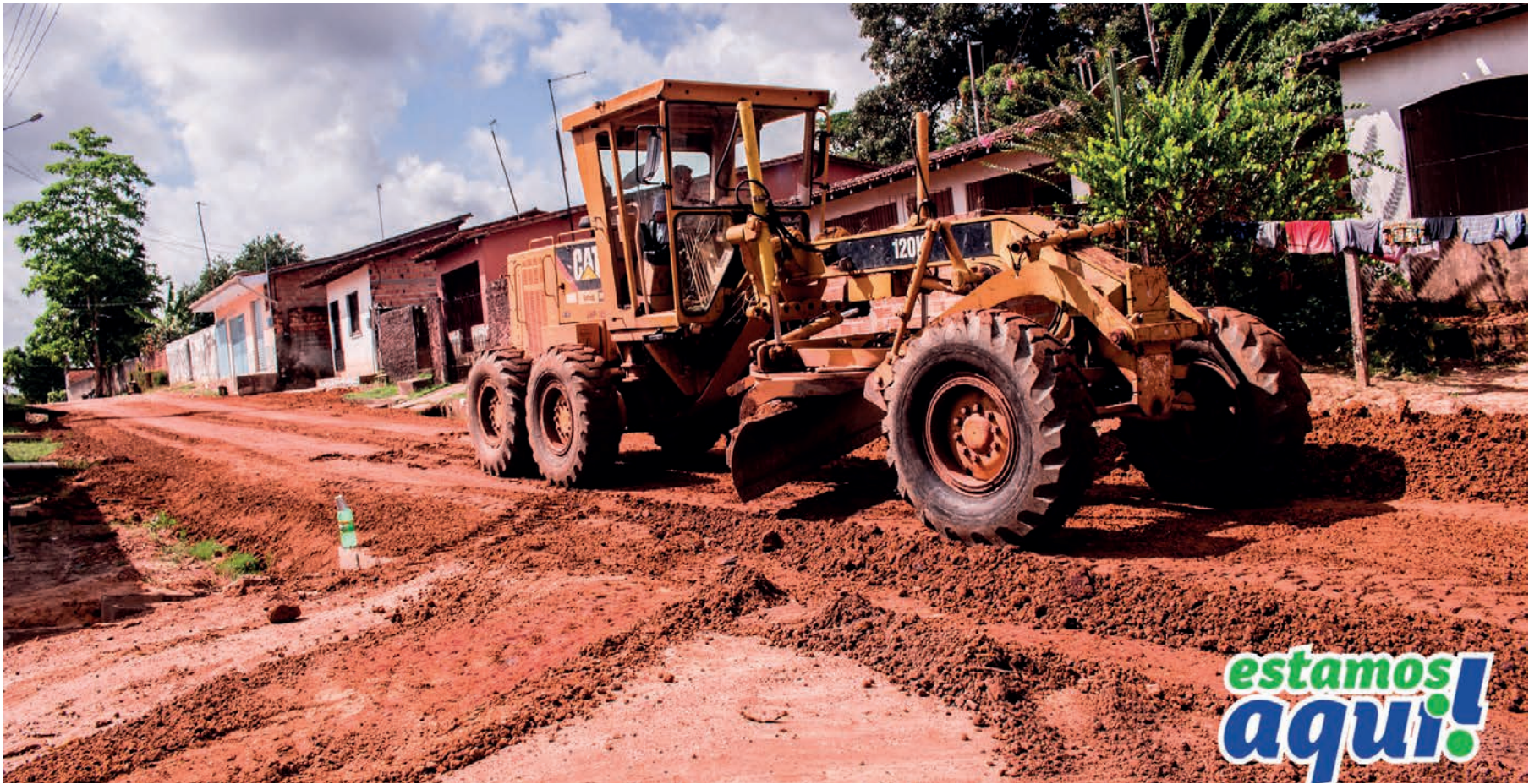
Bairro Novo recebe serviços de infraestrutura (Foto: Babi Afonso)
