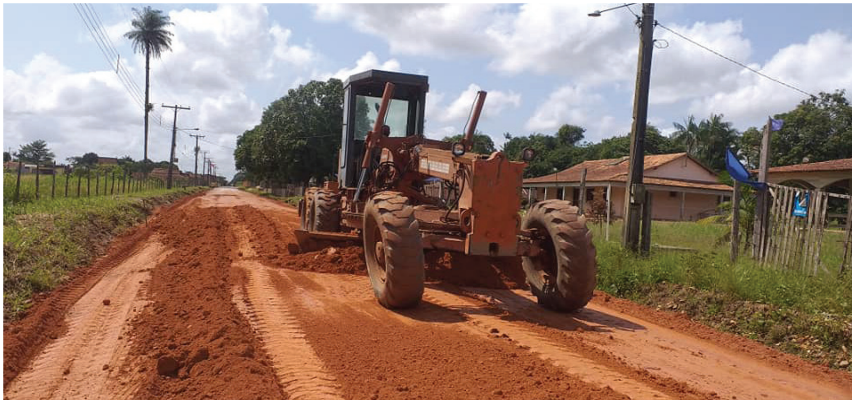
Máquinas seguem trabalho de recuperação de vias
