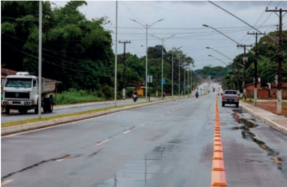
O governo do Pará realizou a entrega oficial da aguardada duplicação e urbanização da PA-412, no município de Vigia, região de integração do Guamá, no nordeste paraense. Pág.03
