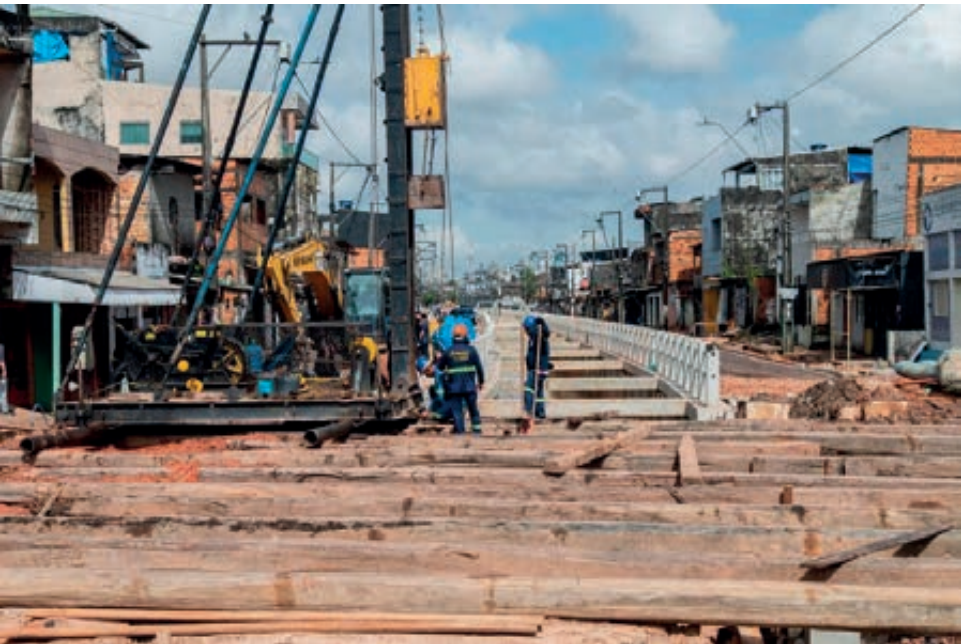
A nova gestão municipal tem honrado o compromisso de preparar a cidade para a COP-30 com: canais limpos, iluminação modernizada, obras estruturantes e investimento em áreas essenciais, com inclusão e melhor gestão administrativa. Pág. 04
